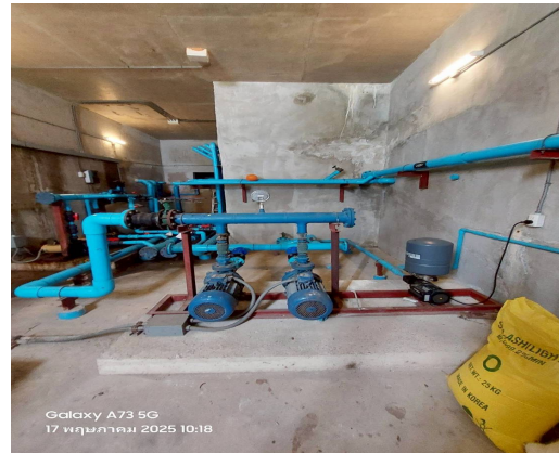
ปั๊มสูบน้ำใช้ขึ้นไป ถังเก็บน้ำชั้นหลังคา
